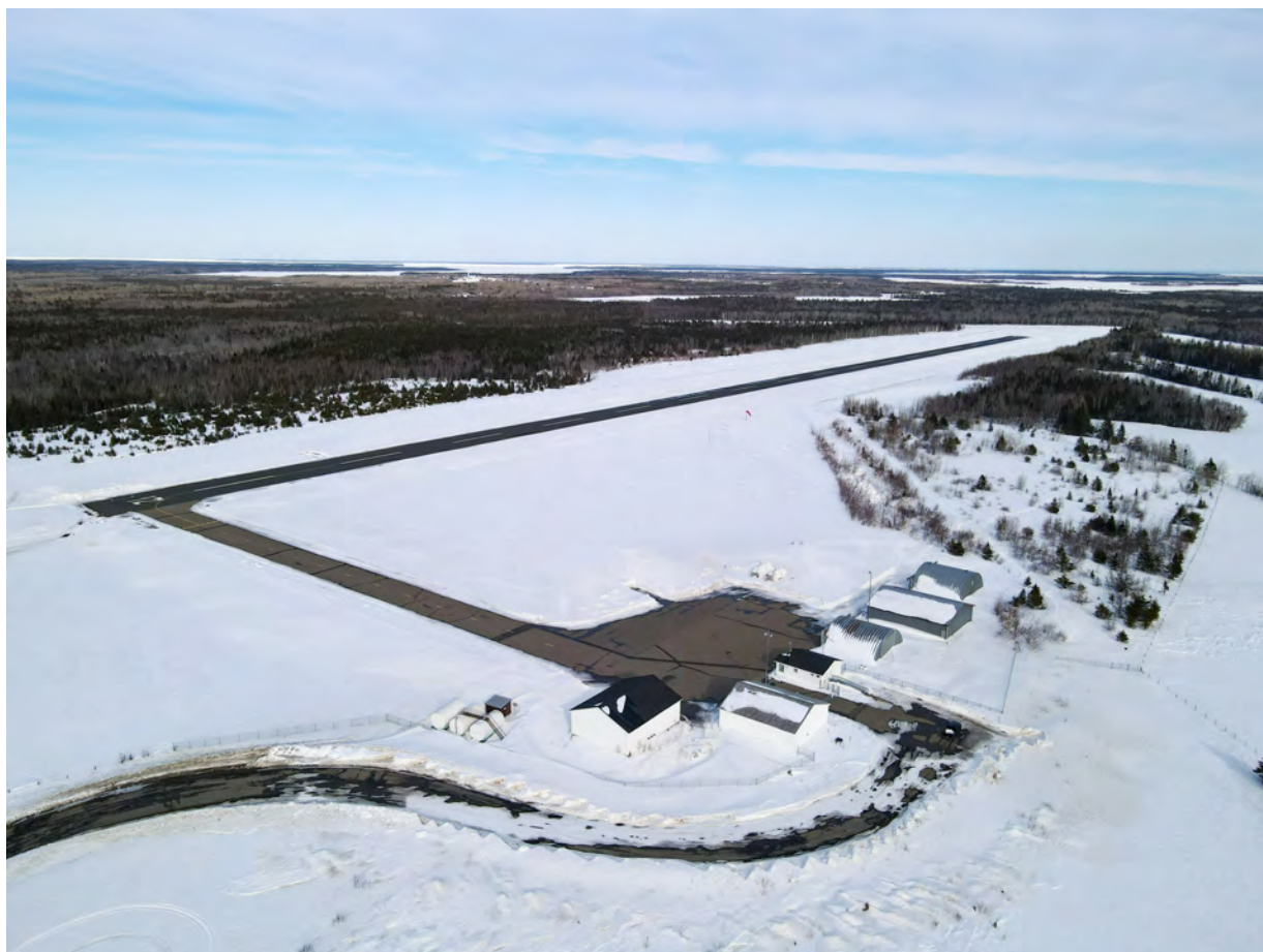
Photo prise lors de l'hiver 2021 qui démontre bien l'ampleur des travaux qui ont été fait pour allonger la piste en 2019 de 400 pieds.
