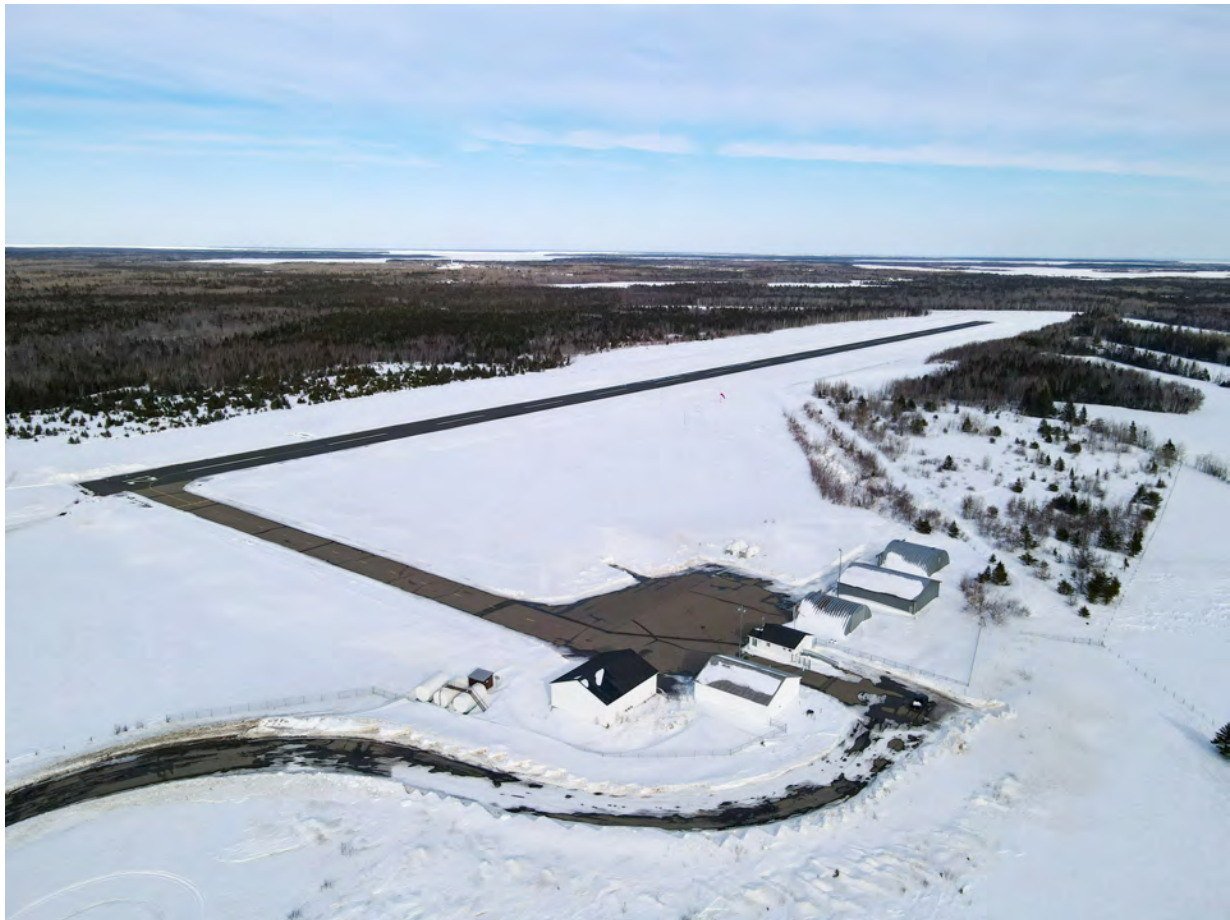
Photo prise lors de l'hiver 2021 qui démontre bien l'ampleur des travaux qui ont été faits pour allonger la piste en 2019 de 400 pieds.
